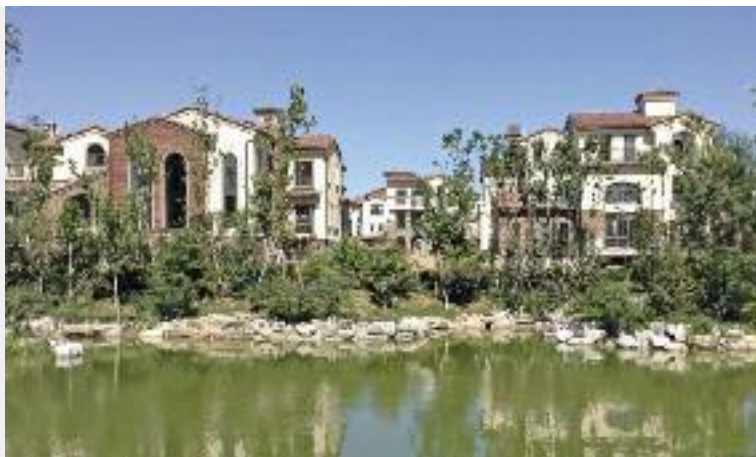
Wohnungsbau Grossprojekte China Large-scale property development project, China
